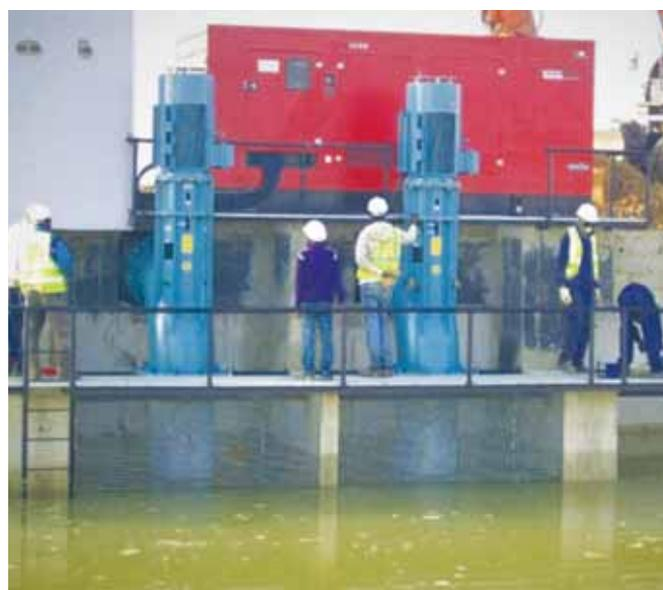
Pompes Chabot V 700 de 4 350 m<sup>3</sup>/h avec système de puissance et régulation dans une installation d'irrigation sur le continent africain
